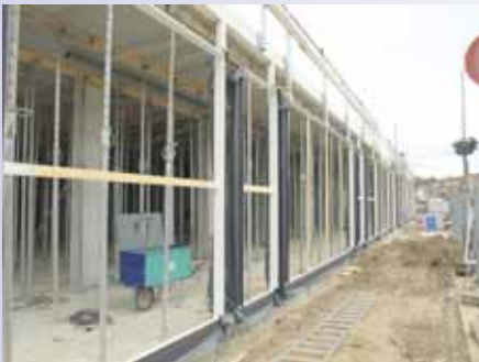
Stelkozijnen gemonteerd in de voorgevel.
