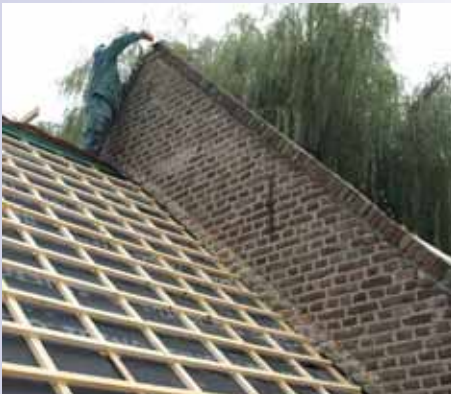
Patrick Vollenberg bezig met het repareren van de rollaag op de topgevel.
