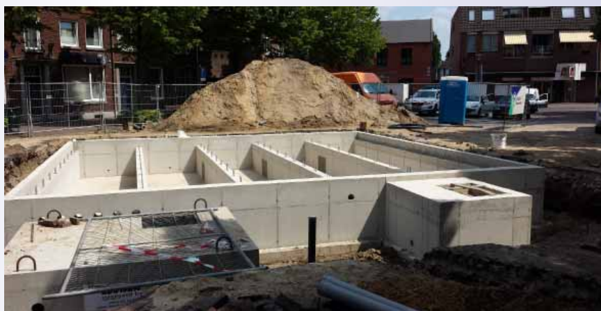
De betonnen (water)bak gelegen onder de fontein.
