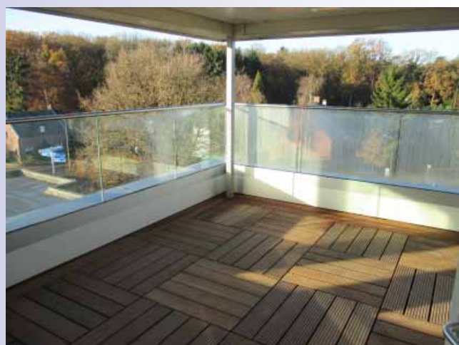
Het nieuwe dakterras.
