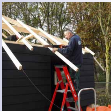
Peter Kallen bezig met de kapconstructie.
