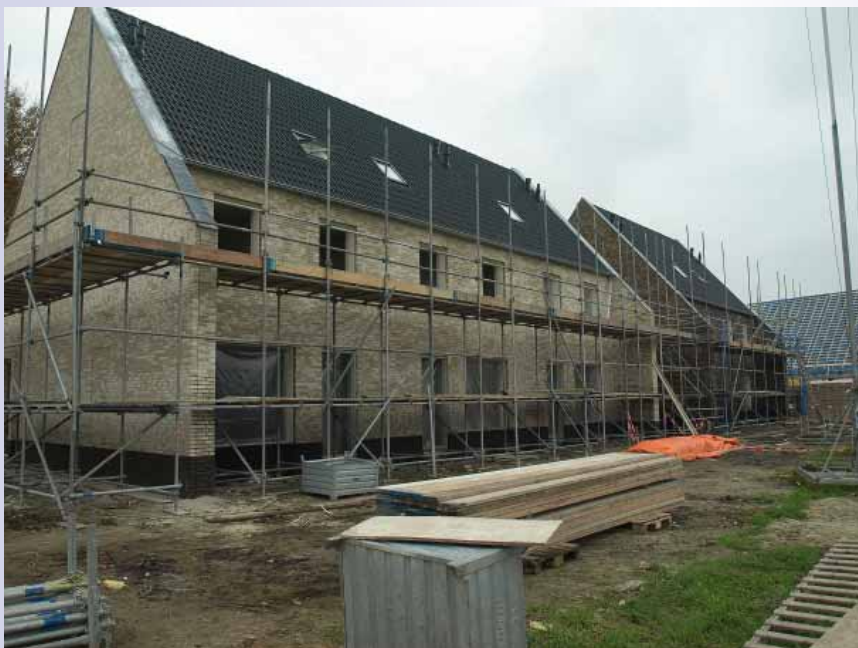
Achterzijde type E woningen.
