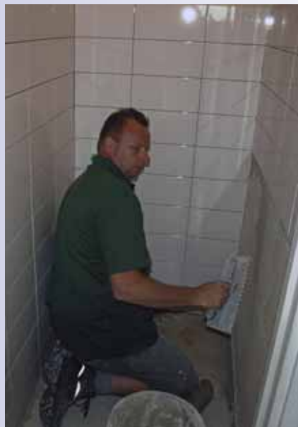
Het betegelen van toiletten en badkamers is een steeds terugkerende opdracht.
