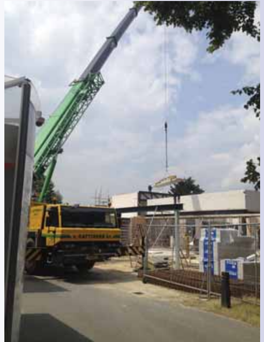
De dakvloer wordt gelegd.
