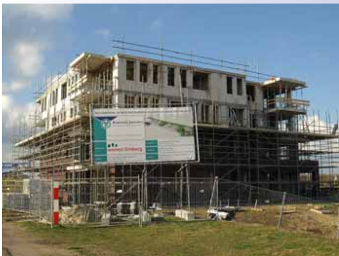
18 Appartementen in aanbouw.
