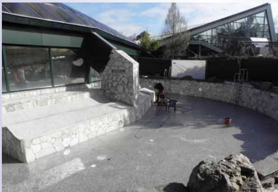
Het buitenzwembad waarvan de vloer en wanden opnieuw betegeld zijn.
