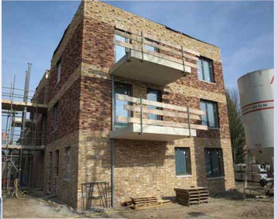
Aanzicht gevel woon-zorgcomplex De Wissel, met de uitstekende koppen in het metselwerk.
