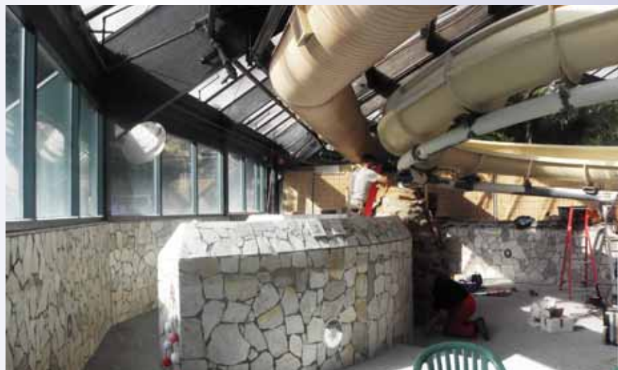
Het tegelwerk van het binnenzwembad is ook vernieuwd en de glijbaan is voorzien van nieuwe bouten en coating.
