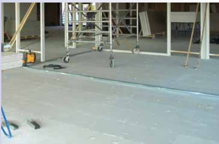
Indeling van de voormalige showroom. Men is bezig met het aanbrengen van de Metal Studwanden.
